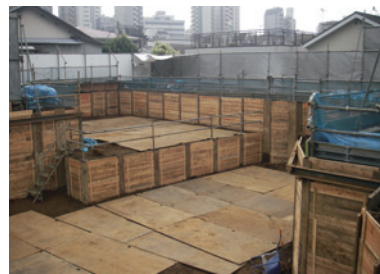
先行根伐工事完了状況
