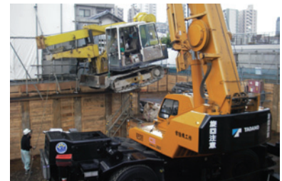
杭重機揚重作業状況
