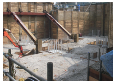
斜梁取付・根伐工事完了
