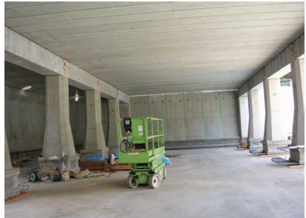
清掃作業も容易な内部空間 (施工中)
