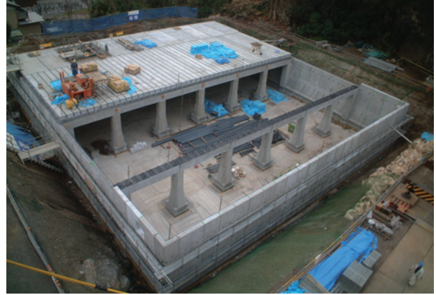
施工状況全景
