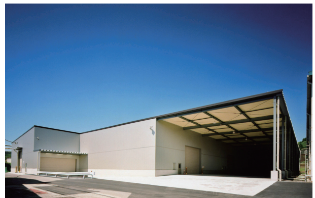
写真 15 穴あき PC 版を採用し建設された某倉庫（福島）
