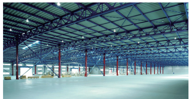
写真5 スパン54mにトラス大梁を使用した工場
