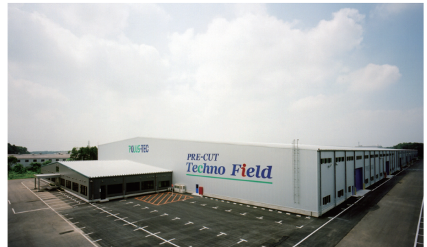
写真 16 木材プレカット工場
