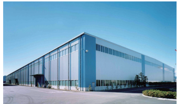
写真 17 鉄骨製品加工工場
