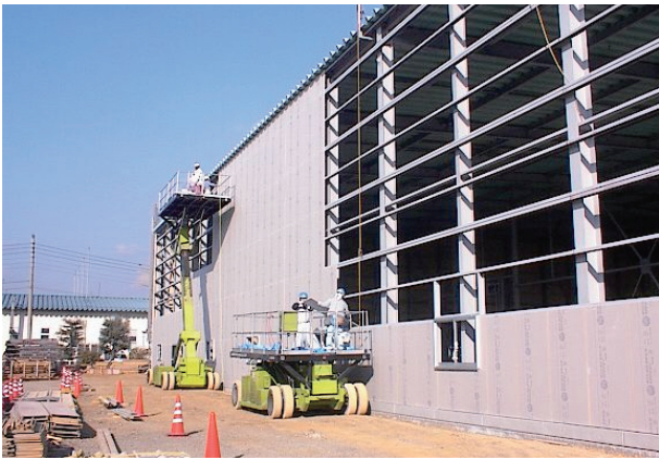
写真 12 無足場工法を採用した某倉庫（栃木）
