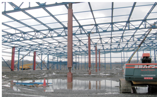
写真11 山留H形鋼工法を採用した某工場（滋賀）
