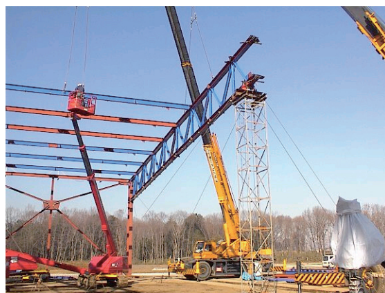
写真10 ベント工法を採用した某工場（茨城）
