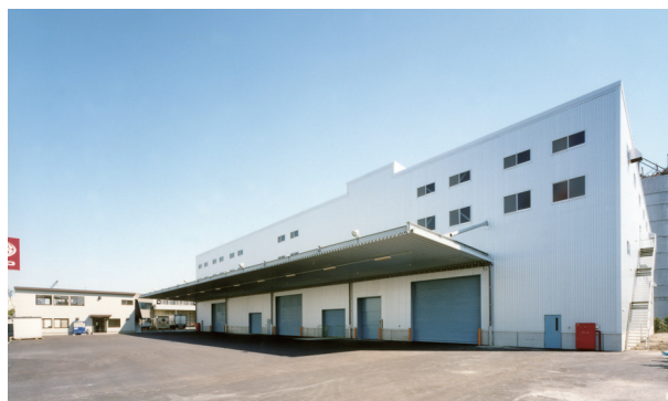
写真 21 金属製品保管倉庫
