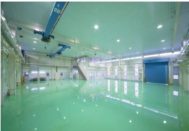
写真 13 高天井の某倉庫（埼玉）
