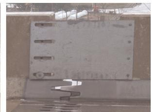
止水板のボルト脱落
