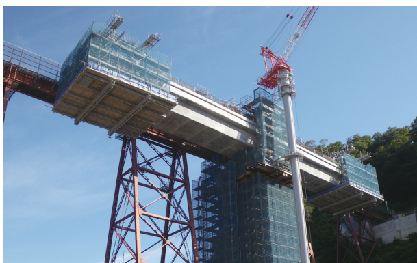
写真 16 張り出し架設の状況
