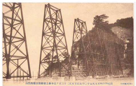
写真7 主桁架設に向けた橋脚間の総足場構築 8) (明治44年9月28日)
