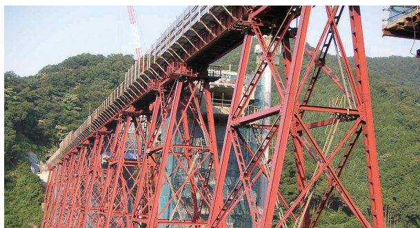
写真12 現存の余部橋梁
