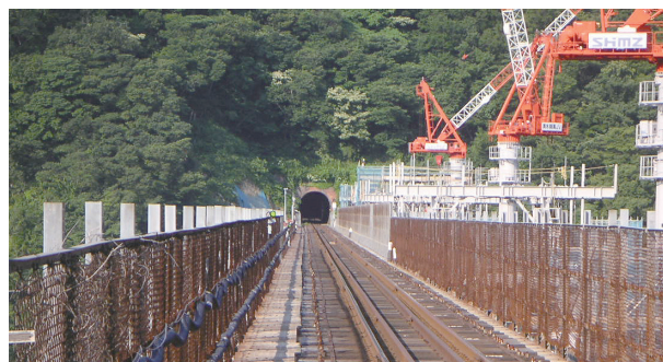
写真14 餘部側から錯側を望む （新橋架設用のタワー・クレーンが隣接している）
