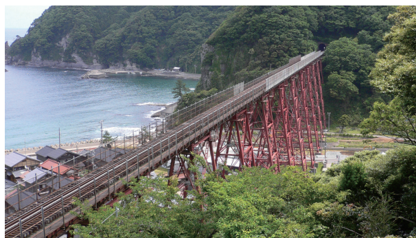
写真2 夏の余部橋梁
