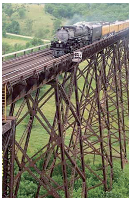
写真8 米国における鋼トレスル鉄道橋 9) （Kate Shelly 橋）
