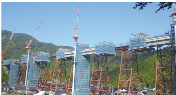
写真 17 平成 22 年度の完成を目指して架設作業の進む新橋
