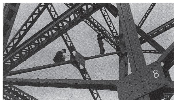
写真10 保守作業の状況 7)
