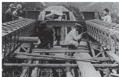
写真3 リベット検査の状況 (中央右の白い制服が岡村技師と推定されている) 7)
