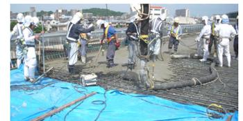
写真6 底鋼板シート養生
