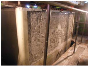
写真10 鋼板撤去完了
