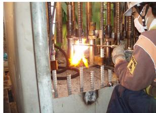
写真 18 主鉄筋ガス圧接状況
