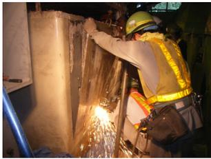
写真9 鋼板撤去状況
