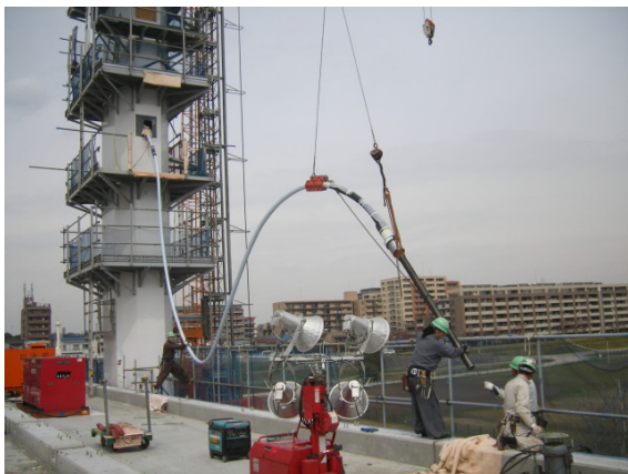
1段目のケーブル架設状況
