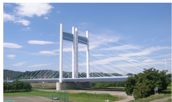
施工完了写真（手前が本工事、奥は既設の1期橋）
