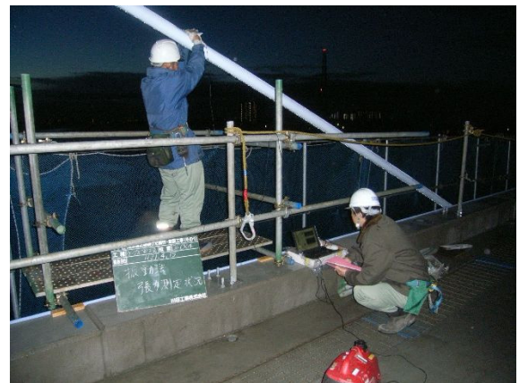
振動法によるケーブル導入張力計測状況
