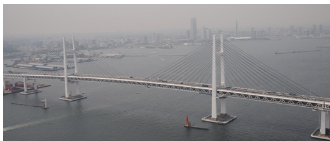
写真 1 横浜ベイブリッジ
