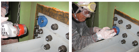
①飛散防止カバーのセット状況 ②研削状況
