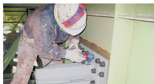
写真3 EZクリーナー研削作業状況
