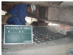
沓座補強鉄筋配置
