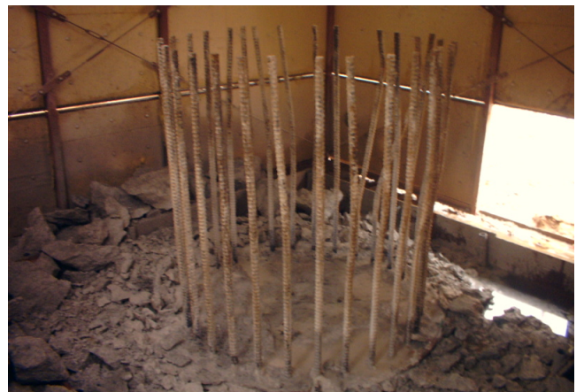
杭頭処理後の《静ちゃん》の内部状況
