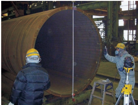
鋼管基準線罫書き状況写真
