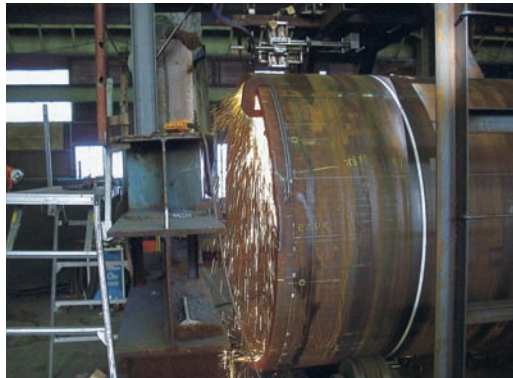
鋼管切断状況写真(全景)
