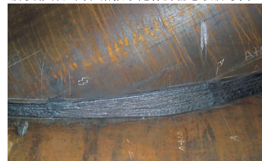
脚長移行区間溶接外観写真
