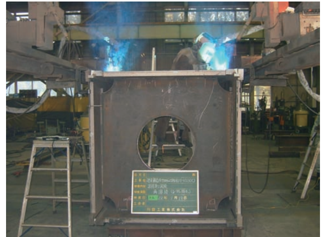
写真 1 直交型自動 CO 2 溶接機を用いた角溶接の様子
