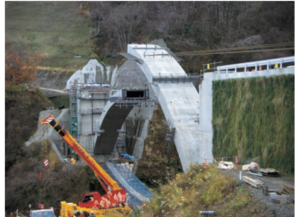
＜ロアリング架設状況＞
