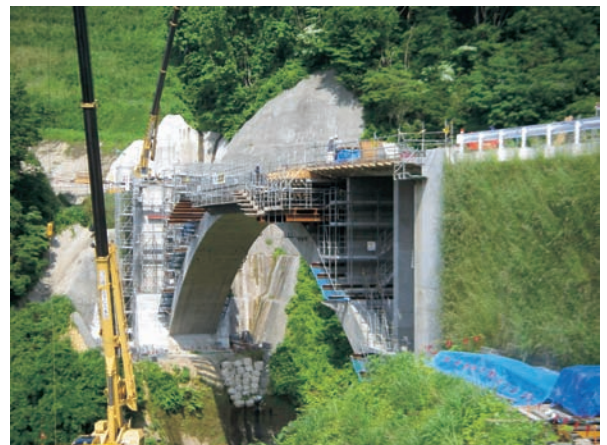
＜鉛直材・補剛桁施工状況＞
