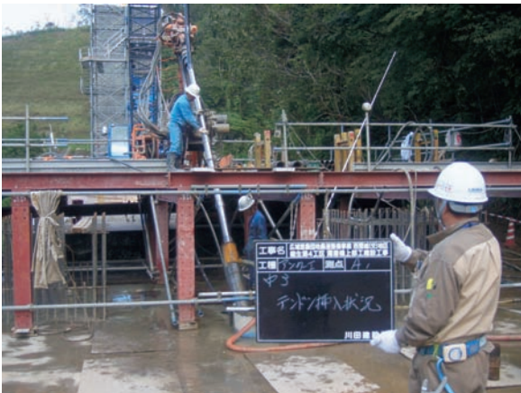
＜グラウンドアンカー施工状況＞
