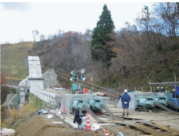
＜ロアリングケーブル4組設置＞
