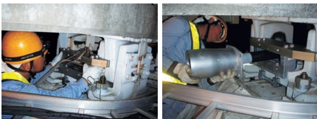
支圧板設置状況
