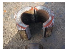
切断されたナットの状況
