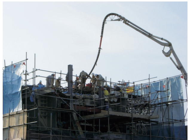
写真8 高流動コンクリート打設状況
