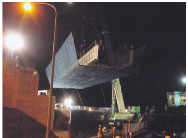
写真9 架設状況写真
