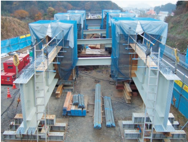
写真10 風防設備設置状況
