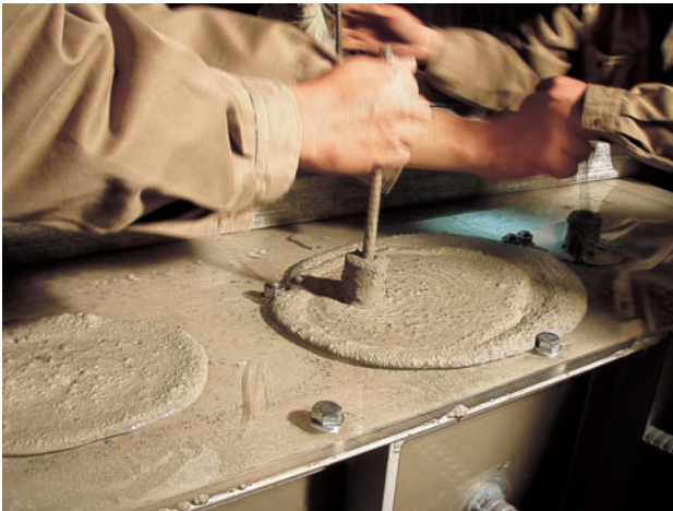
写真6 異形鉄筋による空気孔抜き差し状況
