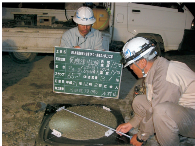
写真3 スランプフロー確認状況
