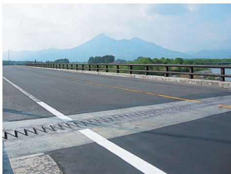
写真10 KMA II-230 取替完了
