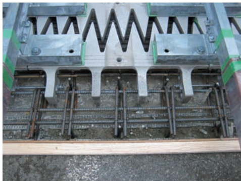
写真9 KMA II-230 のかぶせ筋配筋形状
