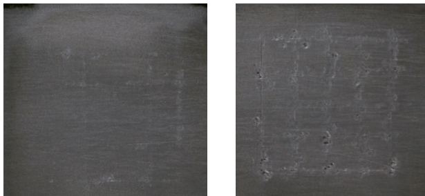
b) 塗膜や錆を除去した状況
