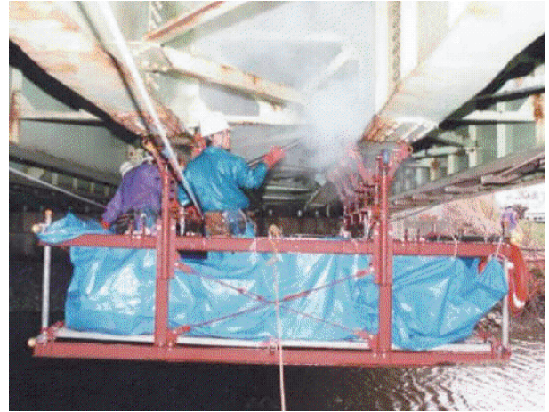
写真2 簡易移動吊足場を用いた洗浄状況
