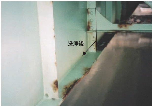
b) 簡易洗浄装置による洗浄(G8 桁海側)
