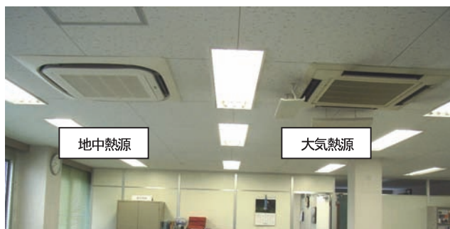
写真3 ファンコイルユニット（室内機）
