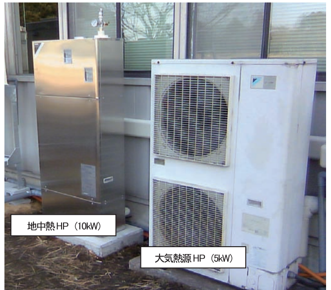
写真2 地中熱HPと従来型の大気熱源HP
