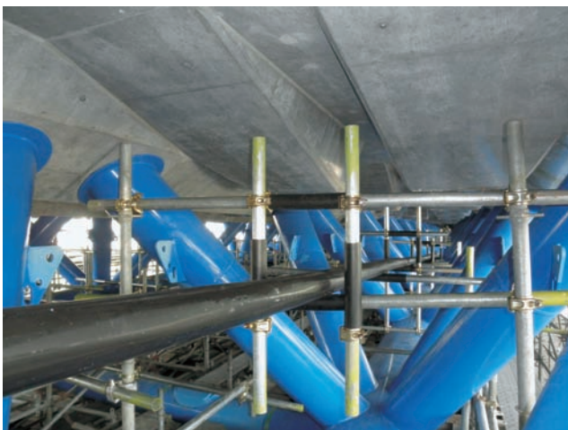
写真7 外ケーブル配置状況
