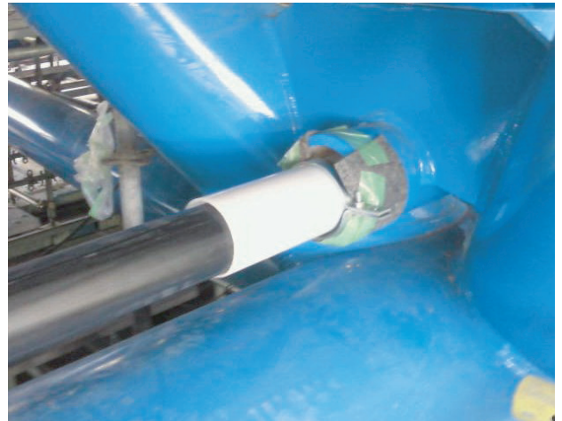
写真8 外ケーブル挿入施工試験状況
