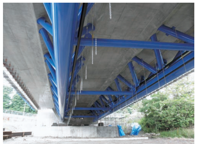
写真1 スペーストラス構造
