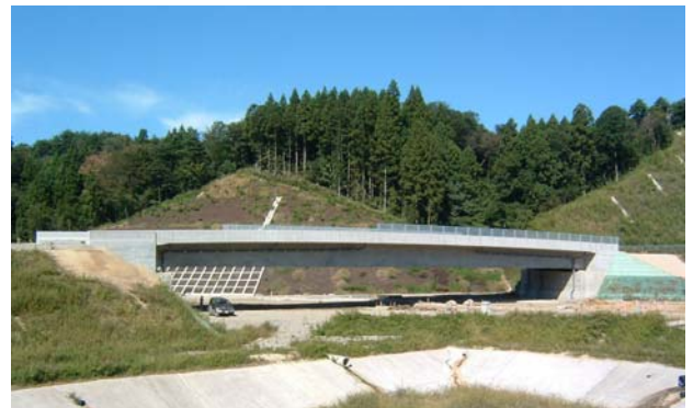
写真5 村上ICランプ橋 全景
