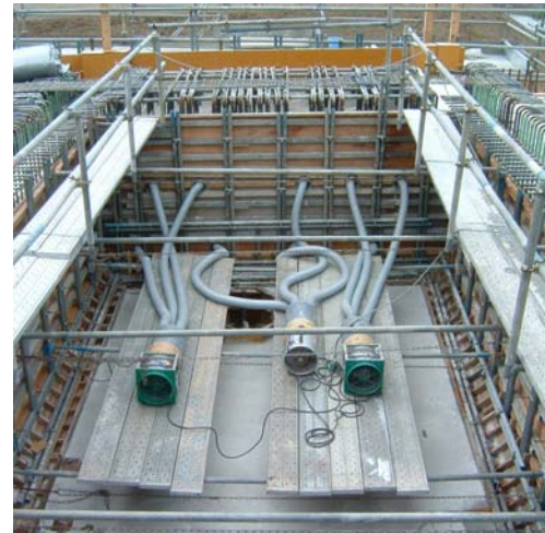
写真2 エアパイプクリーニング設備 全景
