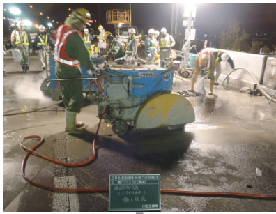
①床版切断
