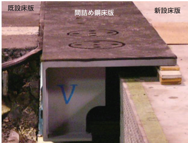
写真3 間詰め鋼床版設置状況
