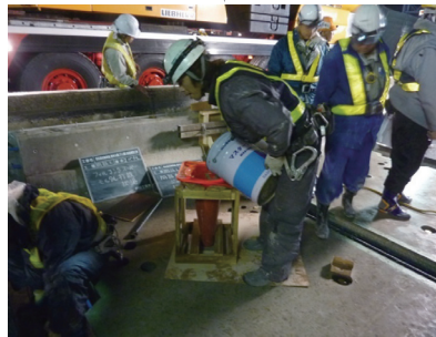
⑤超速硬モルタル打設
