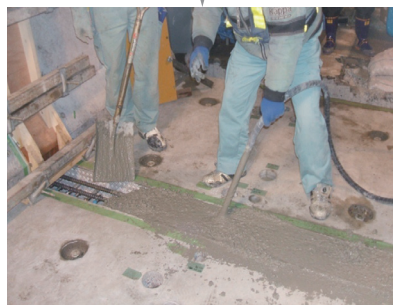
⑥ジェットコンクリート打設
