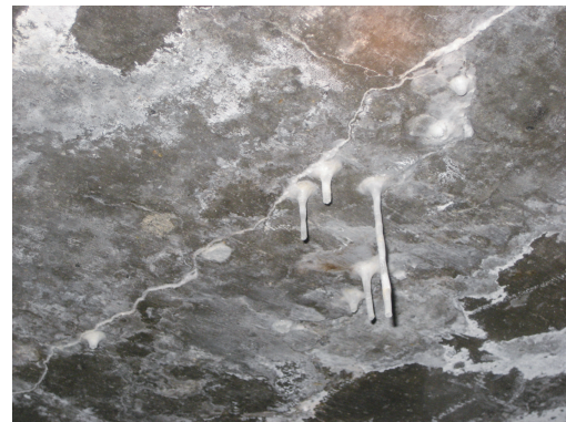
写真1 床版損傷状況
