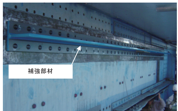
写真2 主桁補強部材
