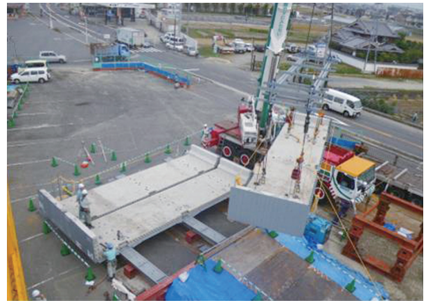
写真5 模擬訓練施工状況
