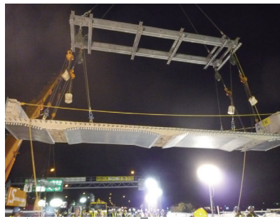
④新設床版据付
