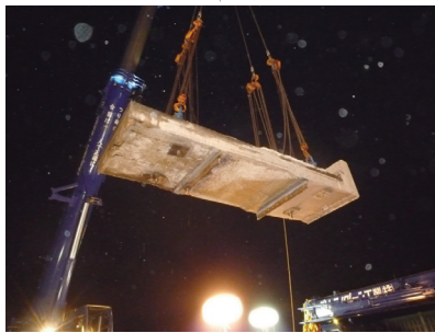
②既設床版撤去
