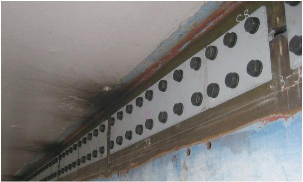
b) 主桁ウェブ仮添接
