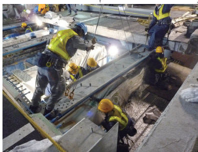
③T字材架設
