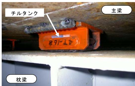
写真8 チルトタンクを用いた主梁の横取り
