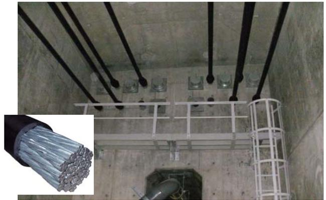
写真9 亜鉛メッキマルチ PC 鋼材
