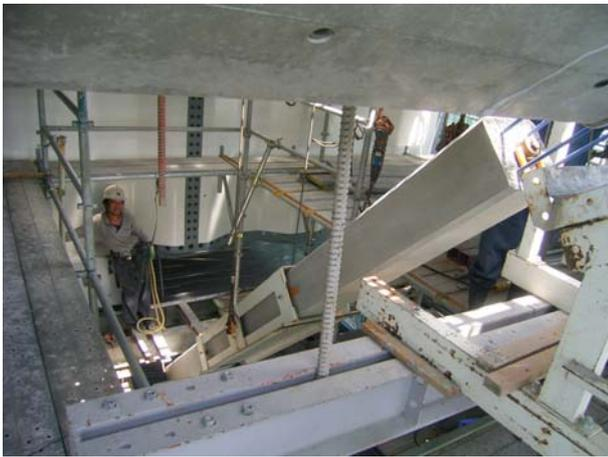
写真17 ストラット架設状況
