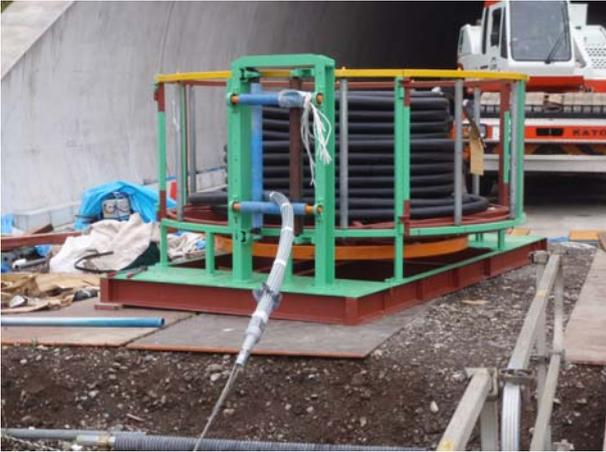
写真 11 垂鉛メッキマルチ PC 鋼材挿入状況
