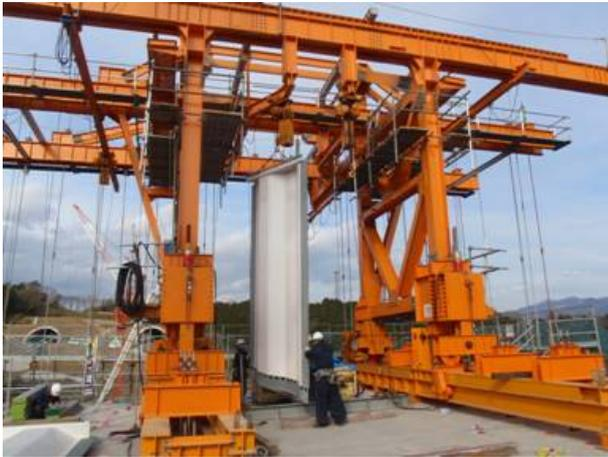
写真16 波形鋼板架設状況
