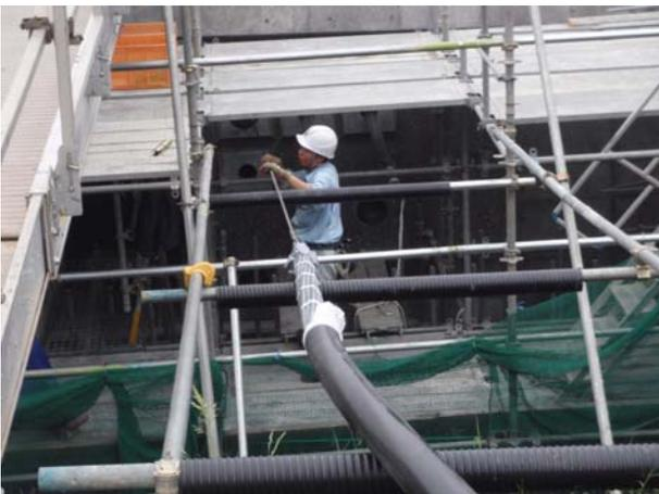
写真 12 垂鉛メッキマルチ PC 鋼材挿入状況
