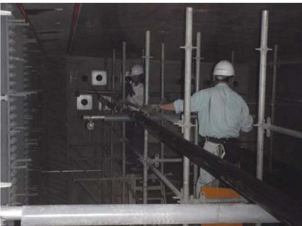
写真 13 垂鉛メッキマルチ PC 鋼材挿入状況
