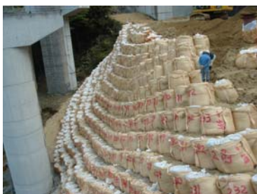
盛土施工状況 と 変更後の架設工法
