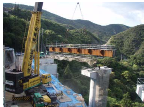
盛土上からのクレーン架設状況
