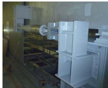
ダンパー取付け状況
