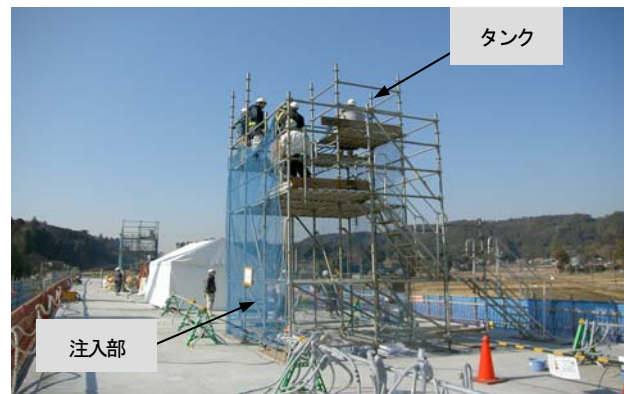
圏央道桂橋（仮称）での施工例
