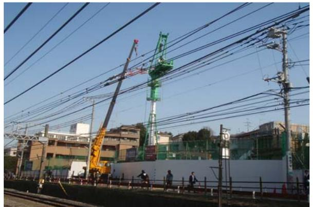
小田急電鉄所有地を利用した タワークレーン建て方状況
