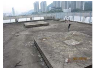
施工前の屋上
