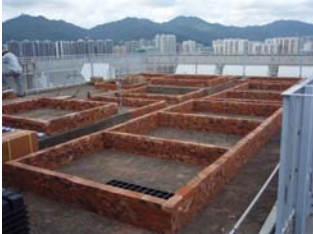
レンガ積み完了
