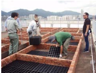
ユニットの設置
