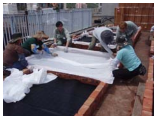
防根シートの設置
