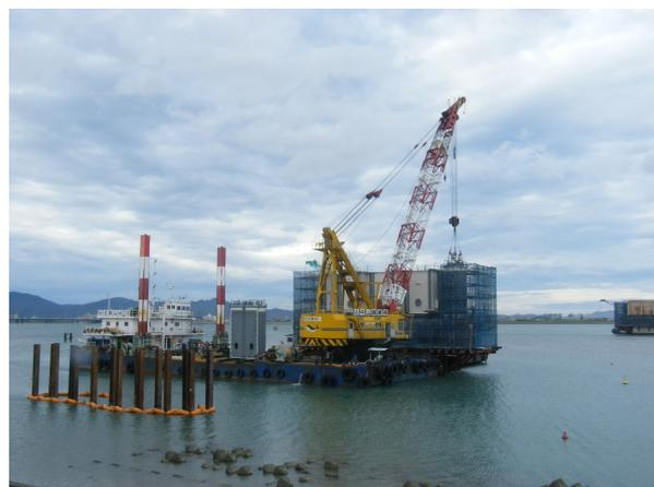
写真4 主塔基部の架設
