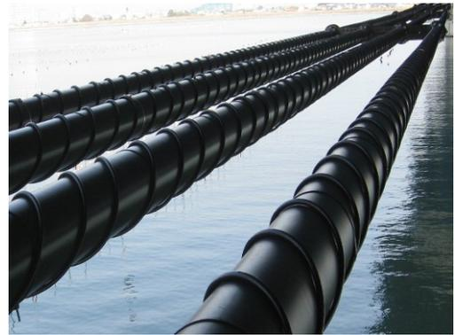
写真3 水平ケーブルの制振対策（ヘリカルワイヤ）
