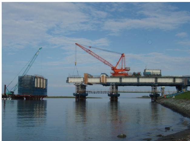
写真5 P1~P2側径間のトラベラークレーン架設
