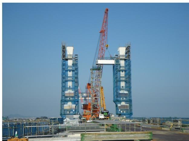
写真9 主塔ストラットの架設
