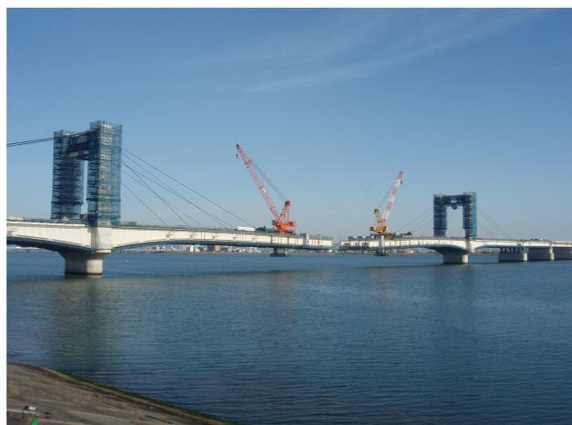
写真7 P2~P3中央径間の架設
