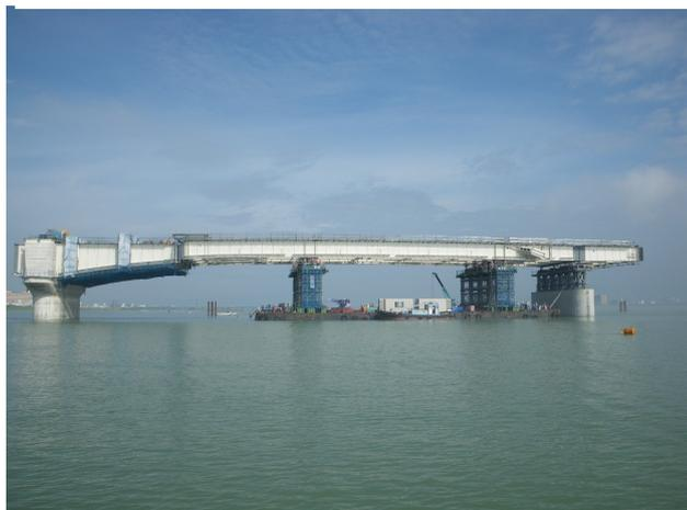
写真6 P3~P5側径間のポンツーン架設
