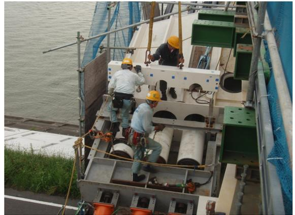
写真12 側径間定着横桁部ケーブル定着
