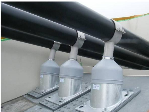
写真2 斜ケーブルの制振対策（高減衰ゴムダンパー）
