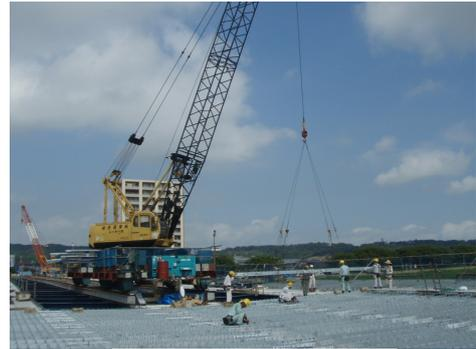
写真13 合成床版架設状況
