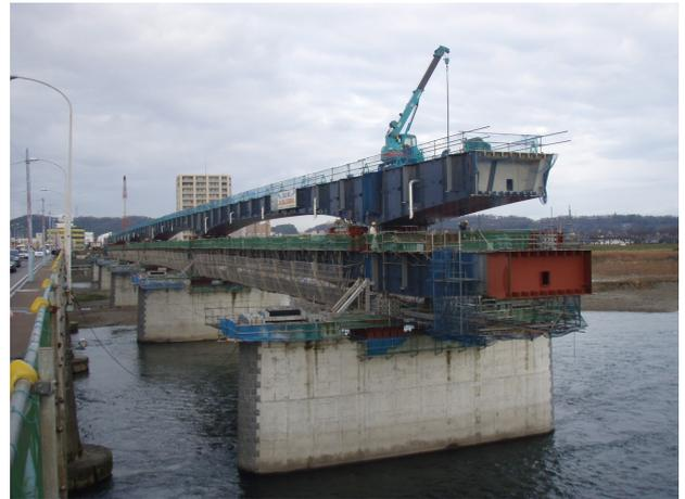
写真7 G1桁送出し完了
