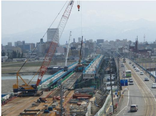
写真11 G3桁横取り完了
