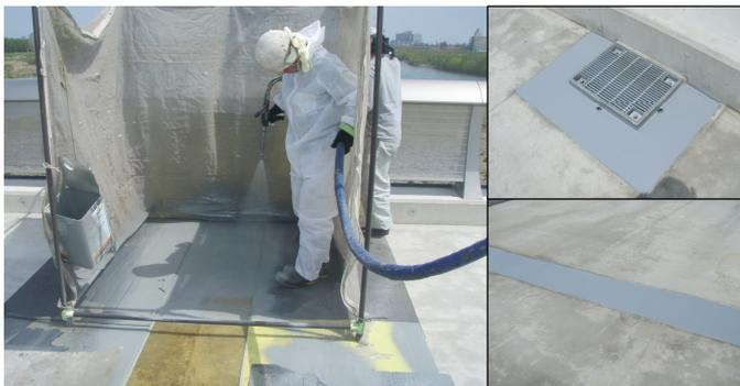
写真17 ジェットスプレー工法施工状況
