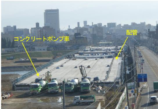
写真16 コンクリート打設状況
