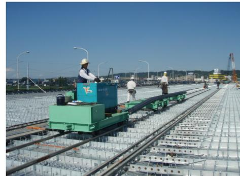
写真15 自走式運搬設備
