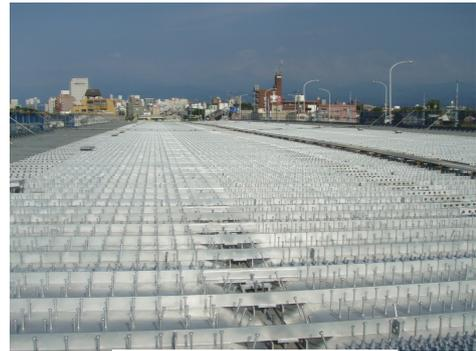
写真14 合成床版架設完了
