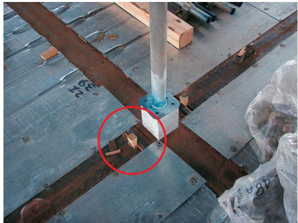
写真6 木製キャンバー設置状況
