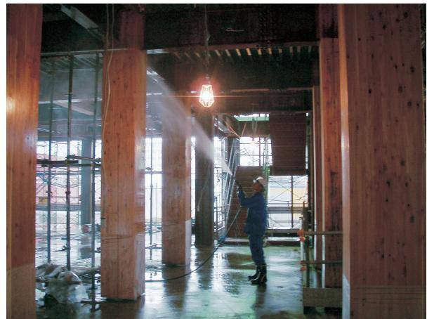
写真12 コンクリート打設時水洗い状況
