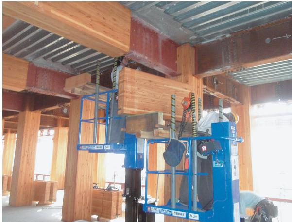
写真8 現場接合部の集成材被覆状況
