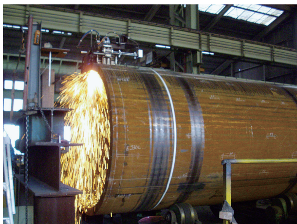
【鋼管切断状況写真 全景】
