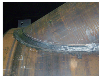
【分岐管トウ側溶接外観】
