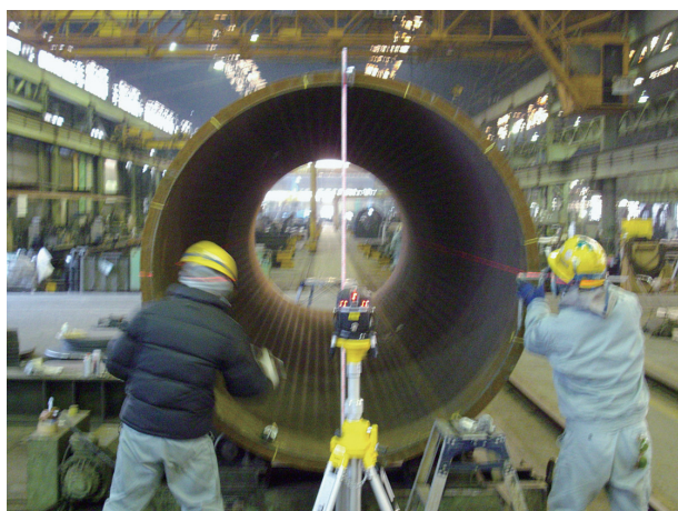
【レーザー墨出し器による野書き作業】
