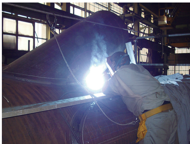
【分岐管溶接作業】
