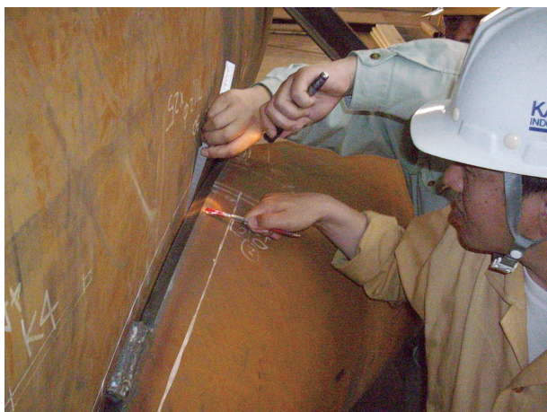
【中間検査 分岐継手すき間計測】
