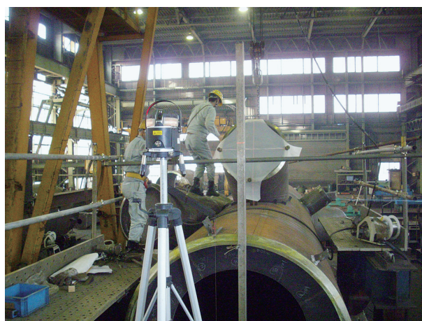
【レーザー墨出し器を使用した分岐管精度確認】
