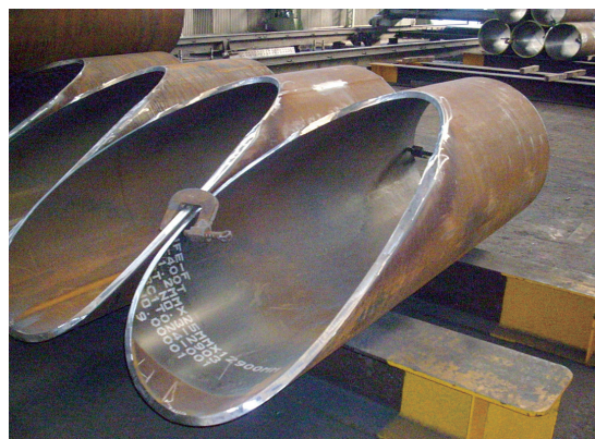
【分岐管切断状況】
