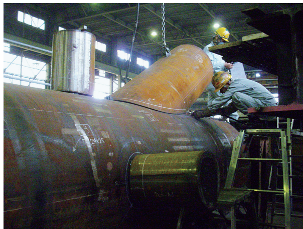
【分岐管の組付け作業】
