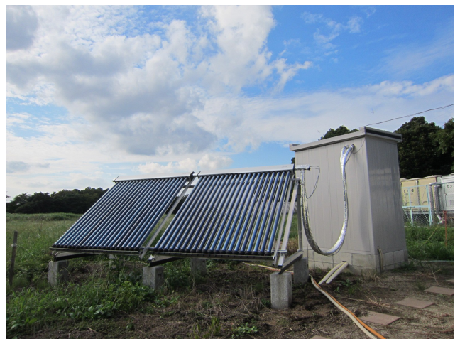
写真1 試験設置した真空二重管式太陽熱集熱システム
