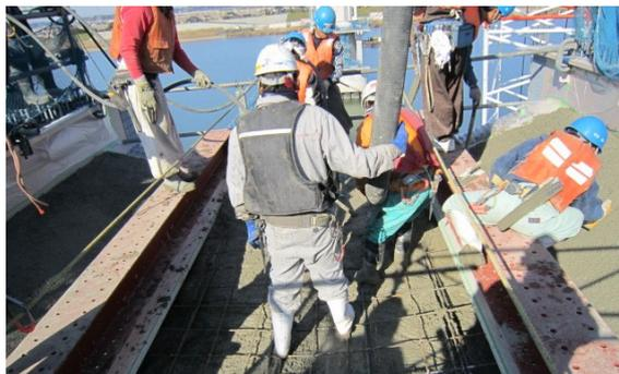
写真8 剛結部コンクリート充填状況
