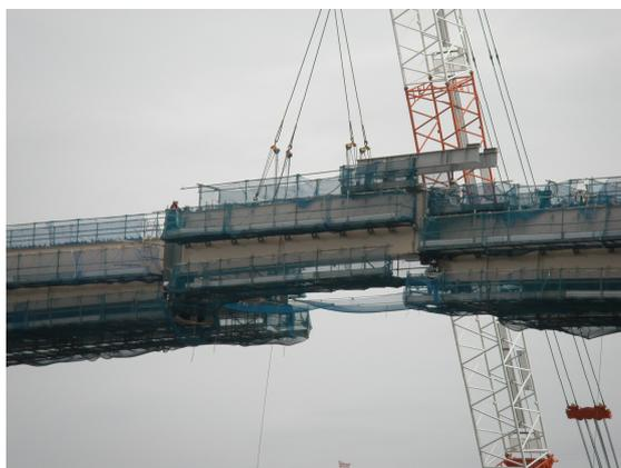
写真9 落とし込み架設
