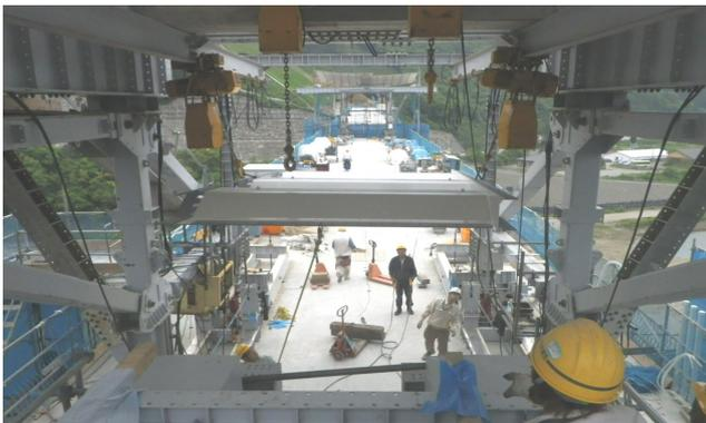
写真4 移動作業車による吊込み状況
