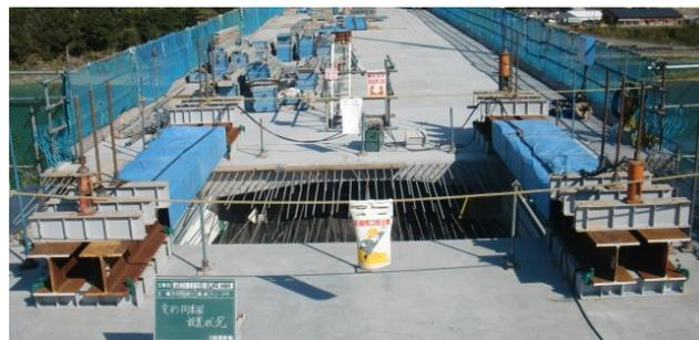
写真7 変形拘束梁の設置状況
