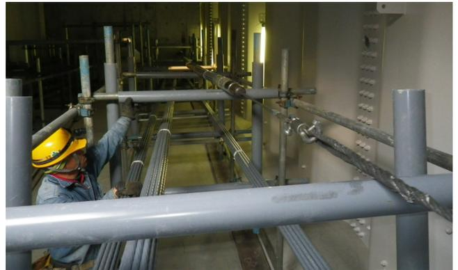
写真9 PC鋼材挿入状況
