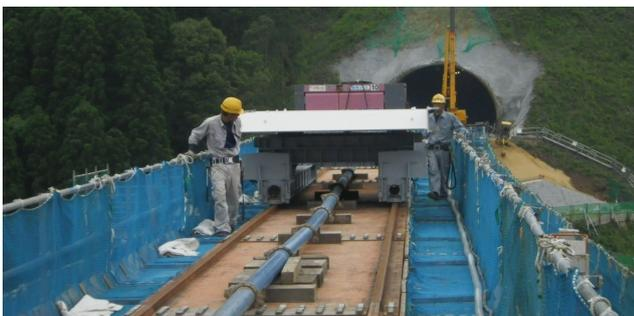
写真3 架設桁上の運搬状況
