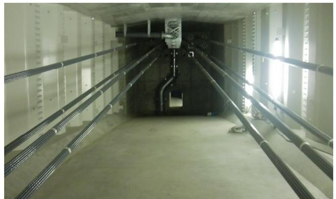
写真10 PC鋼材施工完了後の全景
