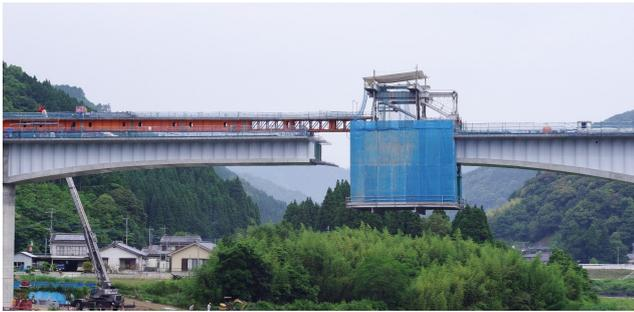
写真2 架設桁施工時近景
