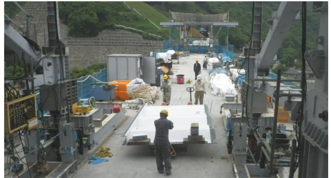
写真5 橋面上の横持ち運搬状況
