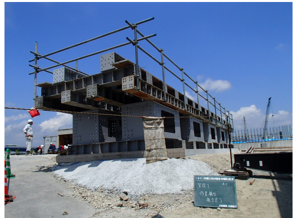
写真6 セグメント桁荷降ろし用構台
