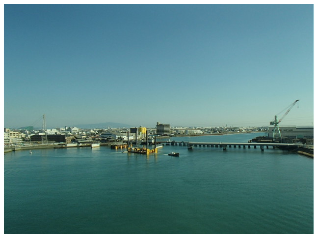
写真12 完成時加賀須野橋全景
