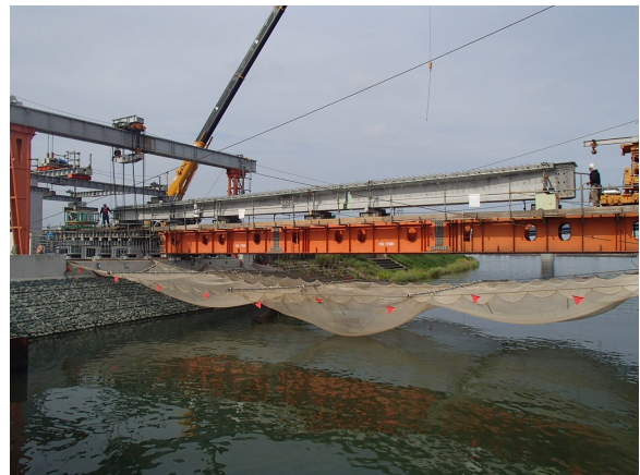
写真7 セグメント桁組立状況1
