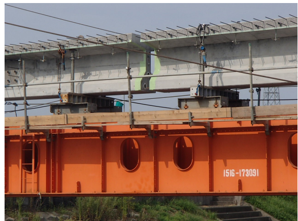
写真8 セグメント桁組立状況2
