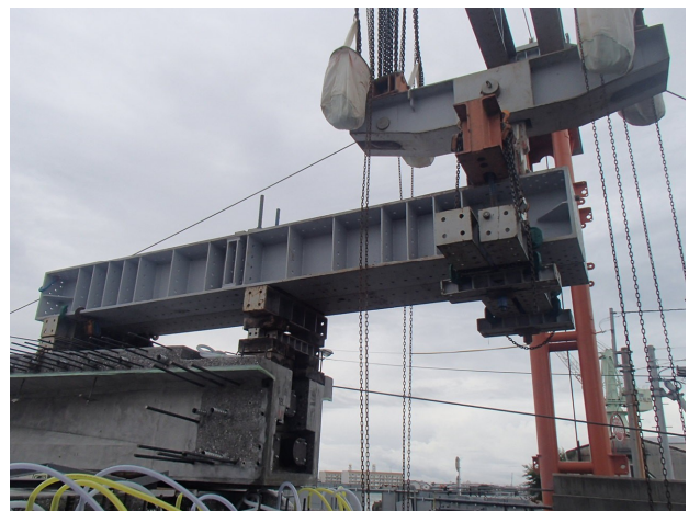
写真10 吊り天秤設置・吊り上げ状況
