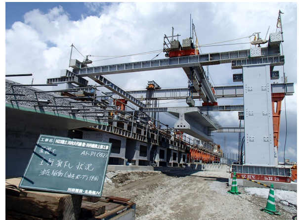
写真3 セグメント桁取り降ろし状況2
