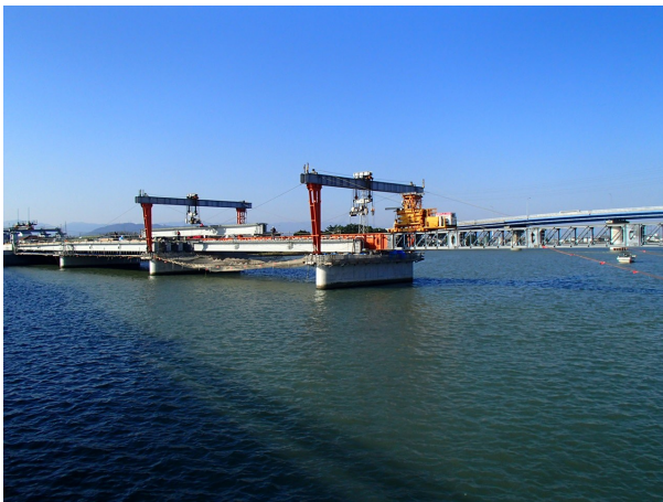
写真9 一組桁（上路式）架設状況
