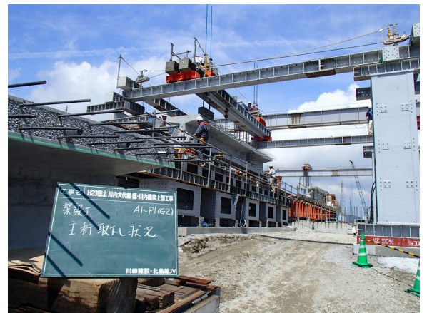
写真4 セグメント桁取り降ろし状況3
