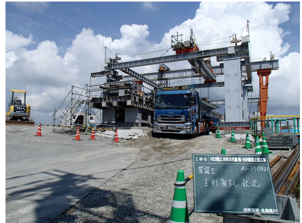
写真2 セグメント桁取り降ろし状況1
