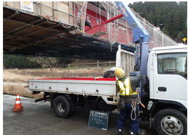
部材取り込み状況
