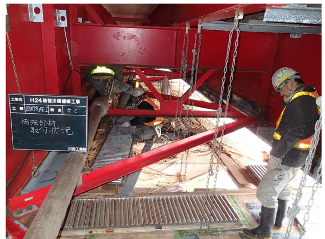
ローラーコンベアーを用いた部材移動
