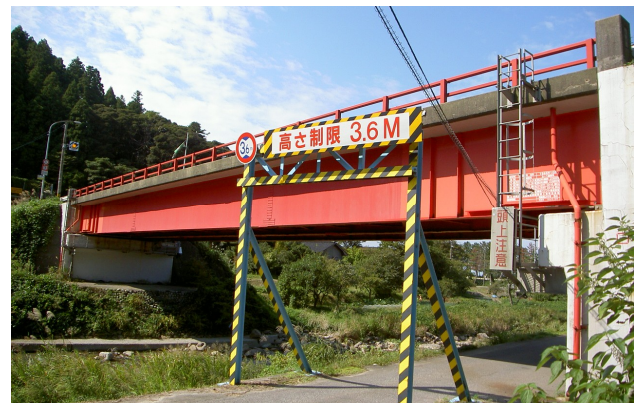
交差状況（右岸上流側町道より）
