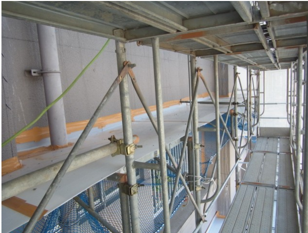
完全養生状況
