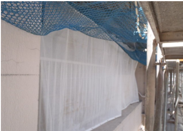
開口部カーテン養生状況
