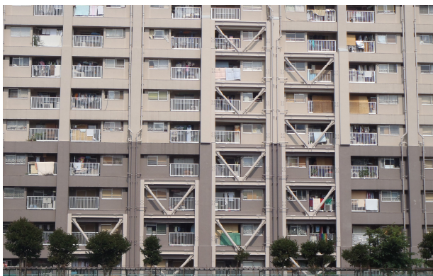
工事完了写真
