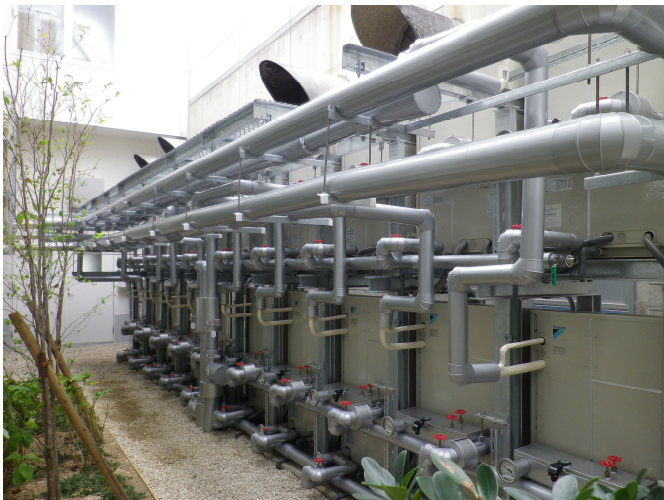
写真1 ヒートポンプ (20台)
