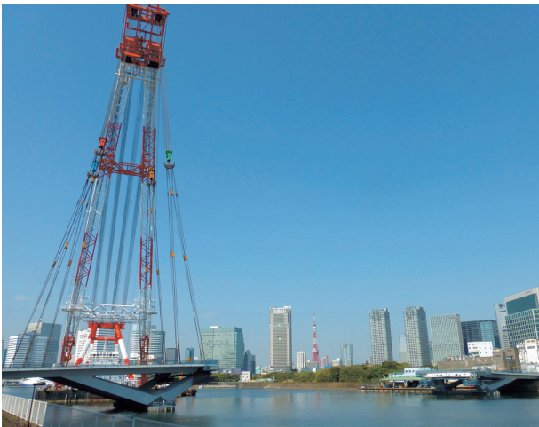
写真6 側径間（P2～A2）ブロック架設状況
