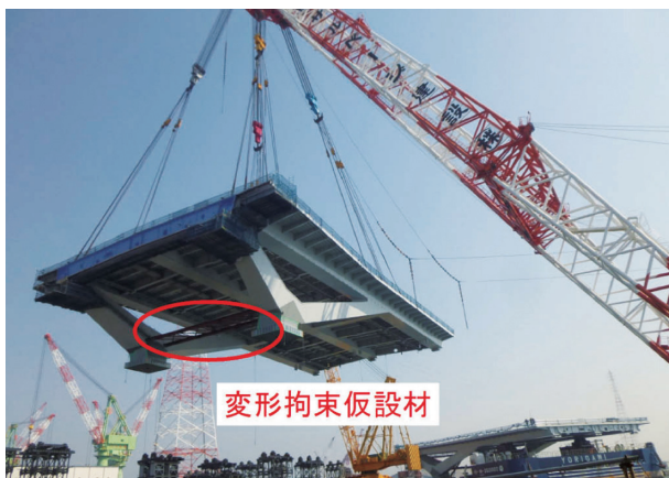
写真1 吊上げ状況（側径間）
