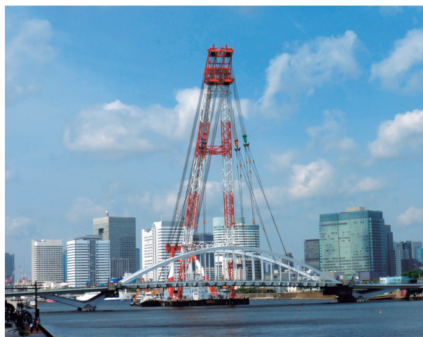
写真9 中央径間（P1～P2）ブロック架設状況
