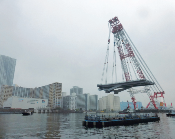
写真5 側径間（A1～P1）ブロック架設状況
