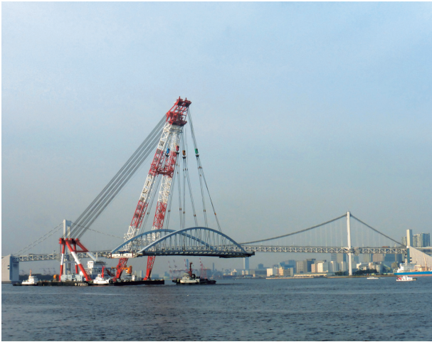
写真7 中央径間ブロックFC曳航状況
