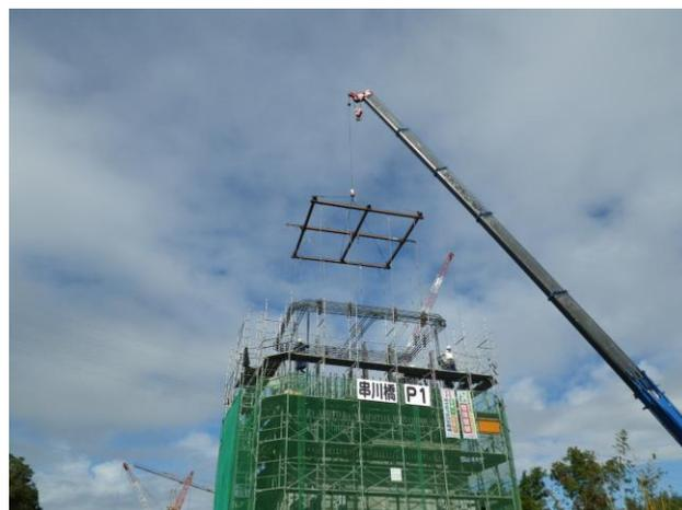
写真7 P1橋脚閉鎖型帯鉄筋架設
