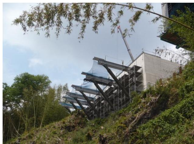
写真10 側径間支保工部大型ブラケット
