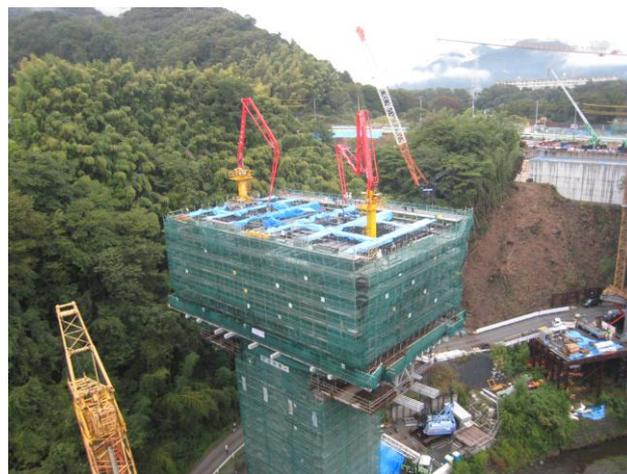
写真 2 P2 柱頭部第 2 リフト打設
