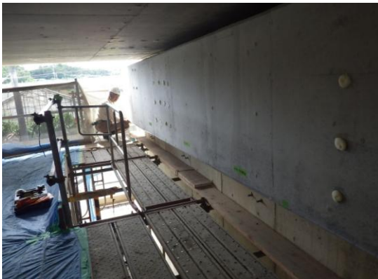
写真 7 カニカラン橋 (下り線) A1 橋台橋座縁端拡幅
