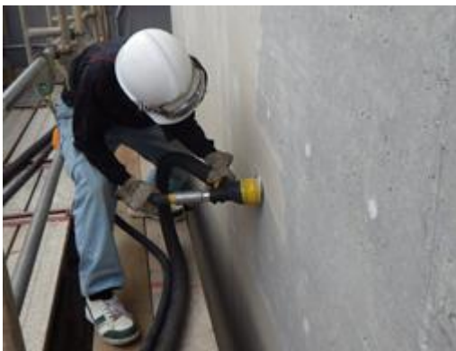
写真4 バキュームブラスト工法
