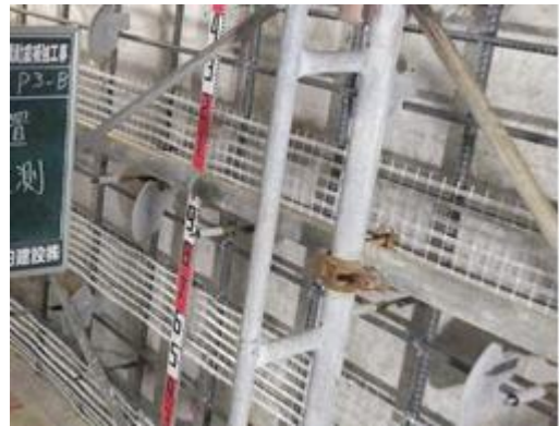
写真5 ハイパーネットの設置
