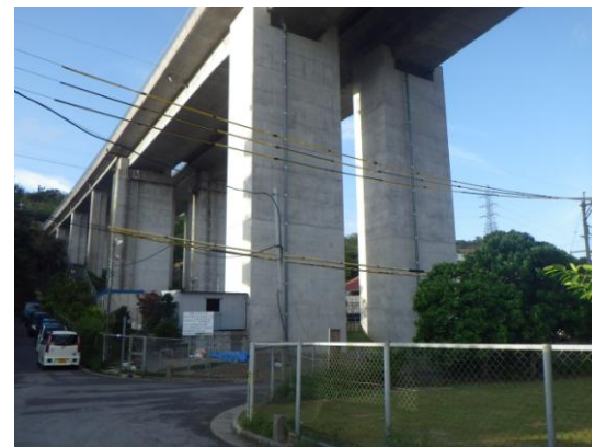
写真 9 屋宜原橋 P3 完成写真
