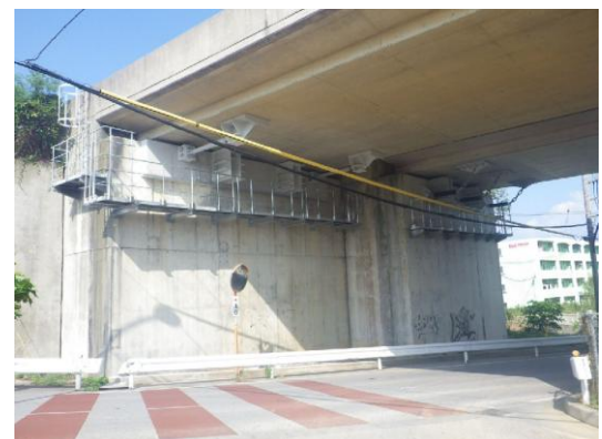
写真 10 カニカラン橋 (下り線) A1 完成写真
