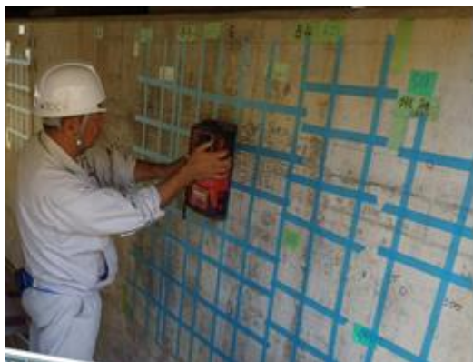
写真 1 RC レーダー調査
