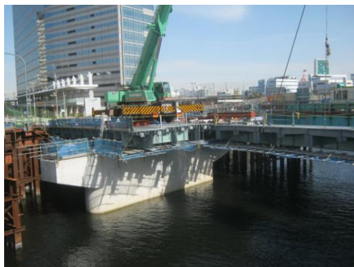
P1～P2 間の架設状況
