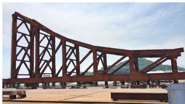
写真 2 立体仮組立全景
