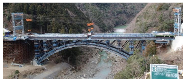
写真 3 落とし込み部材の架設状況
