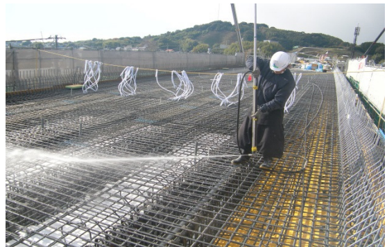
写真4 L字型高圧洗浄器(挿入前)
