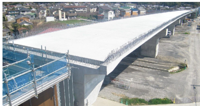
写真 1 秋津高架橋完成全景
