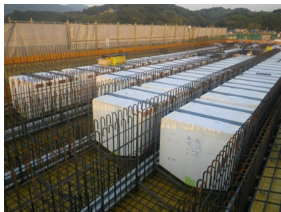
写真 2 配置作業中の発泡ボイド
