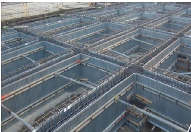
基礎・基礎梁の鋼製打込み型枠施工状況
