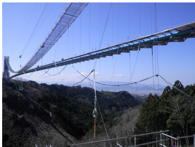
写真13 耐風索架設状況
