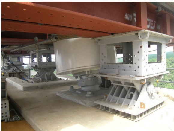
写真7 架設足場基部のヒンジ構造
