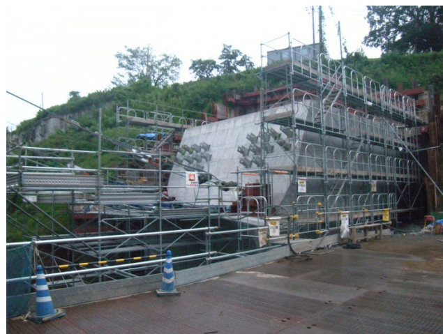
写真4 施工完了後の4Aアンカレイジ
