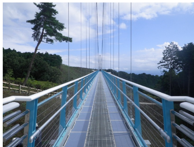
写真14 橋面工（高欄・薄層舗装）施工後の状況
