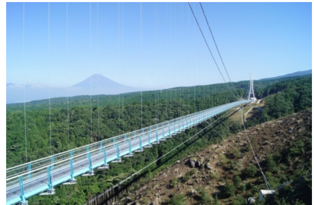
写真1 箱根西麓・三島大吊橋
