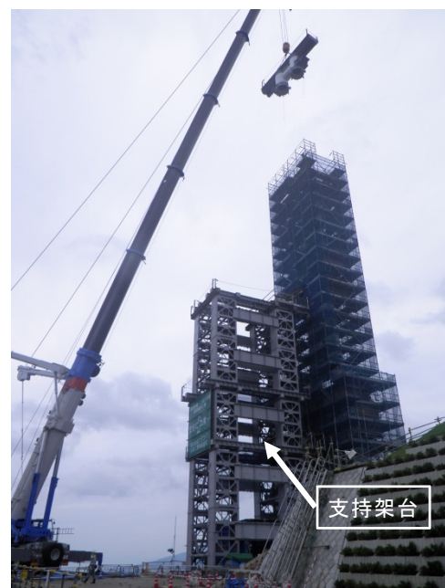
写真6 主塔の架設状況
