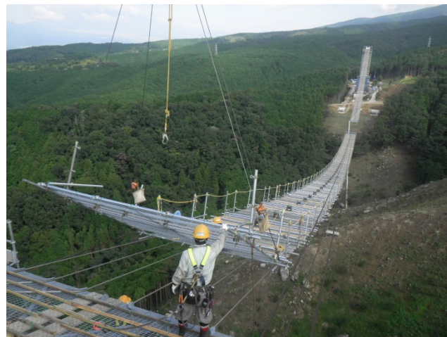
写真11 CW床組パネル架設状況
