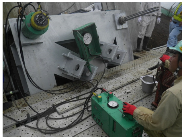
写真5 耐風索鋼製架台のグラウンドアンカー定着
