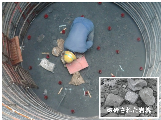
写真3 発破準備作業（装薬状況）
