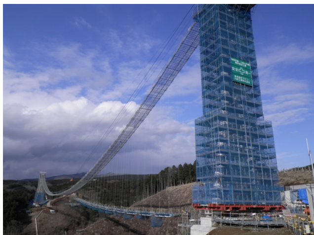
写真12 橋体（床組）架設状況
