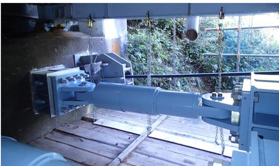
写真8 制震ダンパー設置完了
