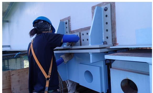
写真3 橋軸方向固定構造 設置状況 (P1 橋脚)
