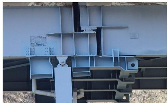
写真2 橋軸方向固定構造 着工前 (P2 橋脚)
