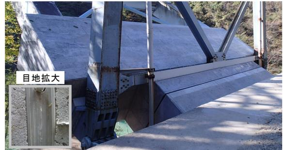
写真 9 アーチ基部コンクリート施工完了 (目地設置状況)
