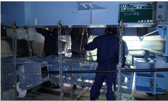
写真7 制震ダンパー設置状況
